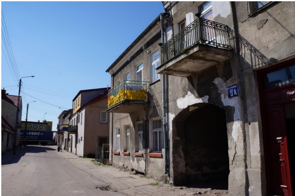
FOT. 5. ZABUDOWA MIESZKALNA PRZY UL. TRAUGUTTA
